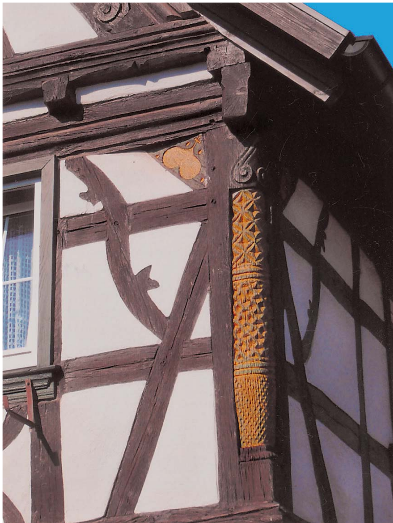
Eckständer eines Fachwerkhuses in Ilbesheim, Kreis Südliche Weinstraße
