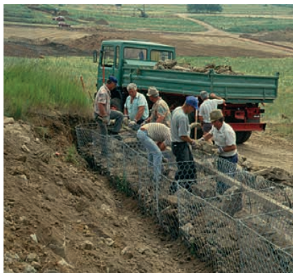
Abb.3: Gabionenbau
