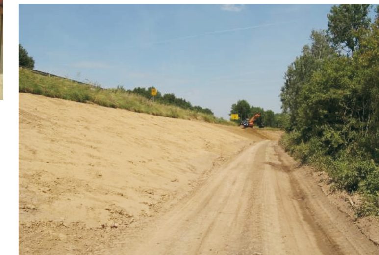
Abdichtung Straßendamm B 9
