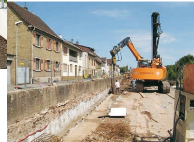
Untergrundabdichtung Hochwasserschutzmauer
