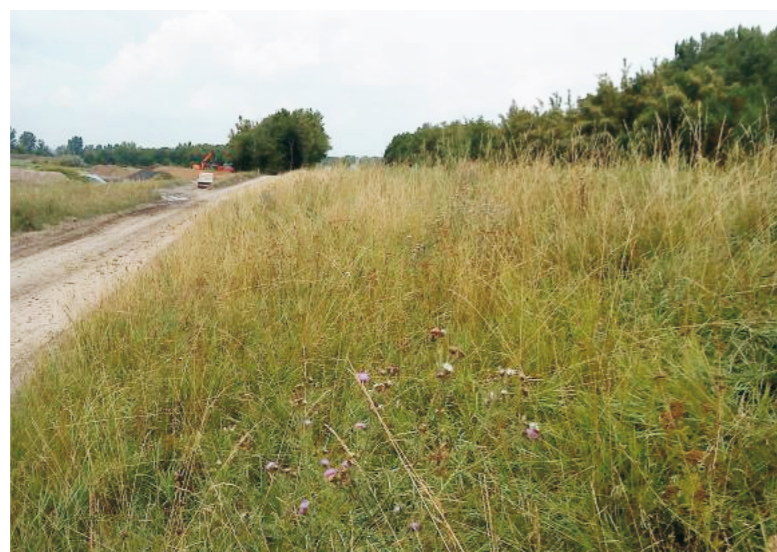
Deichabschnitt mit angedeckten Soden im August 2010
