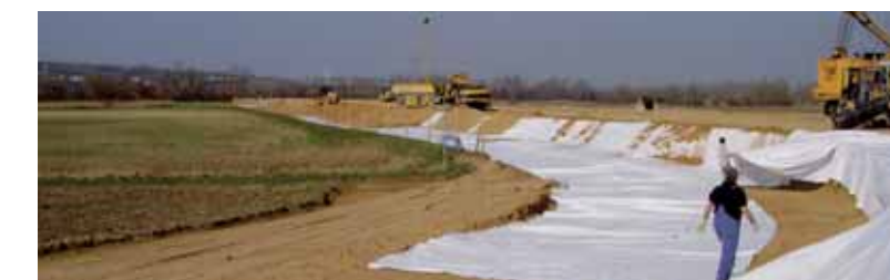
Erdarbeiten am neuen Deich
