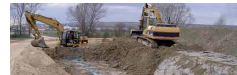
Erdarbeiten mit Dichtwand
