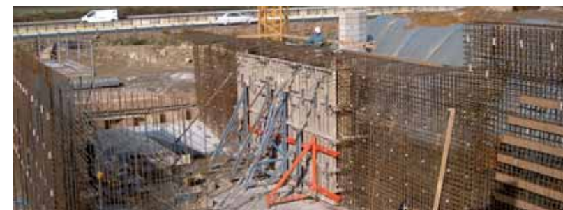
Bauarbeiten am Ein- und Auslassbauwerk
