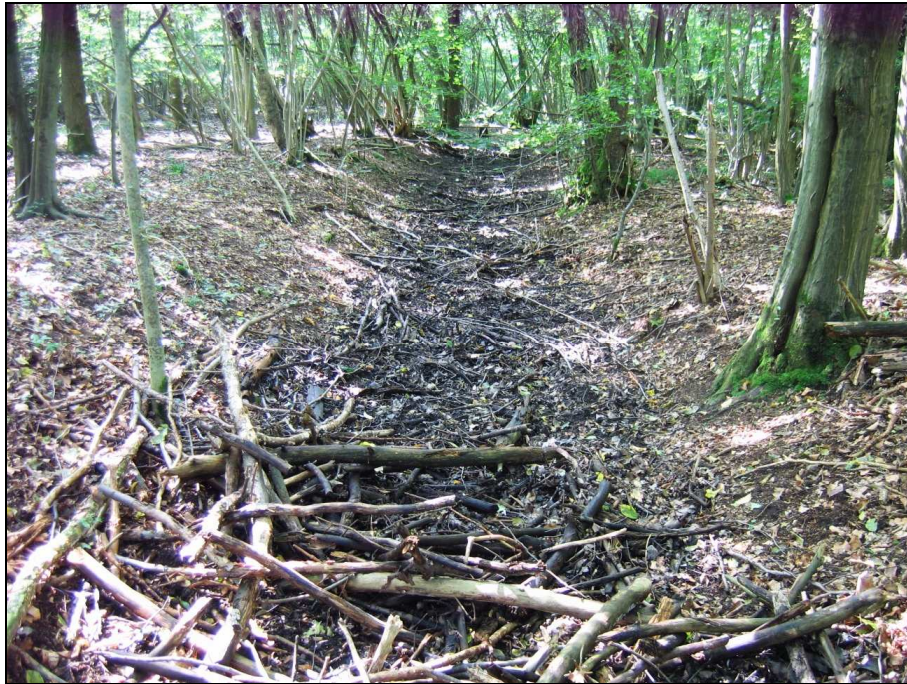
Abb. 5: Verfallener Entwässerungsgraben im Hochstädter Wald (06.08.2010)
