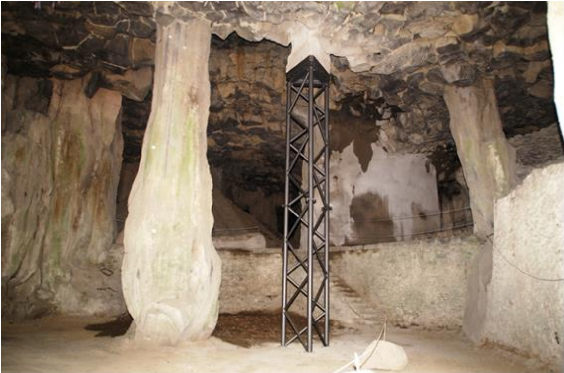
MAYKO-Bierkeller im Mayener Grubenfeld. Die Stahlsäule (ca. 10 m hoch) und die dahinter befindliche Betonsäule wurden im Rahmen des Naturschutzgroßprojektes als Sicherungsmaßnahme eingebaut.
