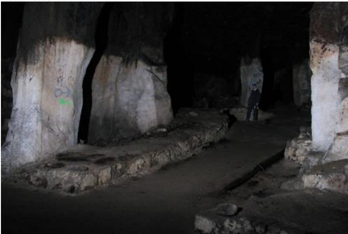
Typischer Bierkeller in Niedermendig: die Räume sind vom Schutt freigeräumt und zwischen 6 – 8 m hoch.
