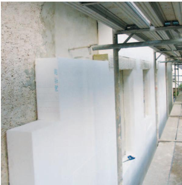
Bild 29: Wärmedämmverbundsystem mit Polystyrol
