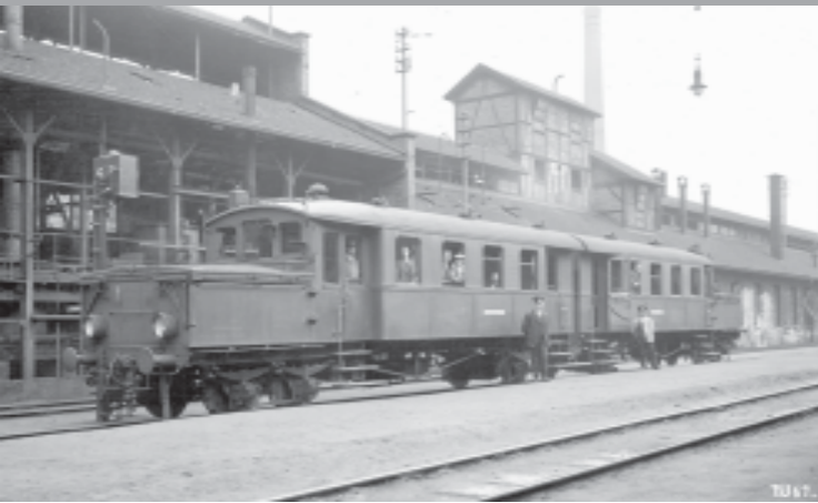
Im Werksgelände der BASF wurde der werkseigene Wittfelder Batterietriebwagen am 27. Juni 1927 fotografiert. Foto: Slg. Klaus Decker/W. Löckel
