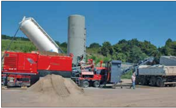
Abb. 10: Mobile Kaltmischanlage (KMA) – Kaltrecycling in-plant (Foto: Fa.Kutter GmbH)
