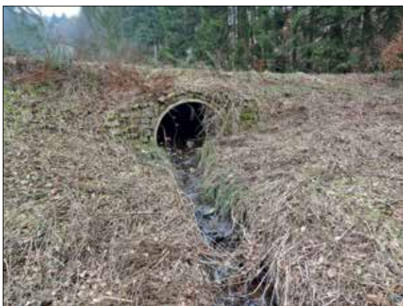
Abb. 19: Gelände nach Umgestaltung und Einbau des Rohrdurchlasses.
