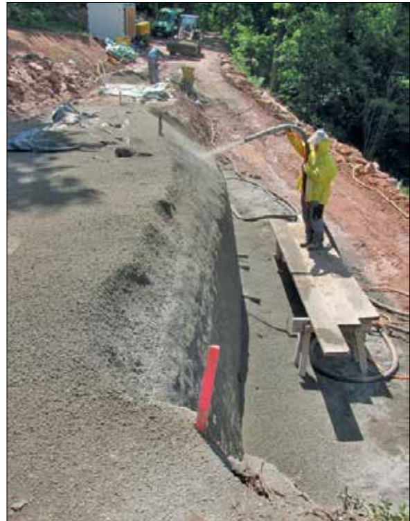
Abb. 17: Spritzbetonschale, Erlenbach am Main (ADD)
