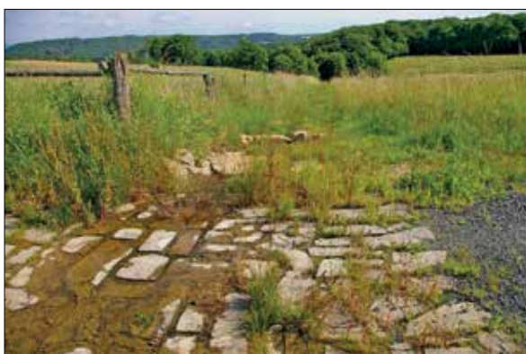
Abb. 26: nach Fertigstellung. Die Natursteinriegel sollen die Eigendynamik des Gewässers fördern und Sohlrosion verhindern.
