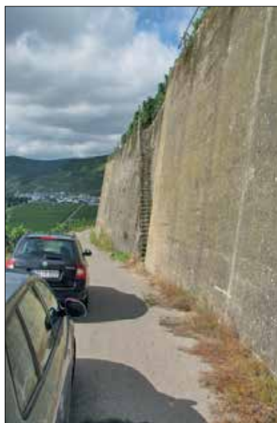
Abb. 10: Betonmauer, Osann Monzel (DLR Mosel)
