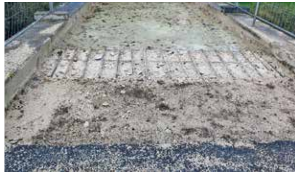
Abb. 6: Plattenoberseite nach Entfernung des bituminösen Belags und der beidseitigen Geländer.
