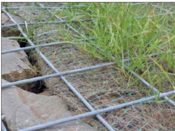
Abb. 12: Gabione mit Mattenabdeckung und Ein- saat, Nittel V (ADD)
