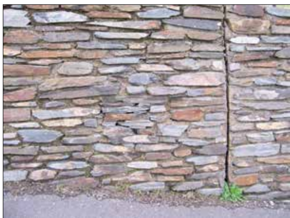
Abb. 9: Vermörtelte Natursteinmauer mit Eidechsenfenster, Bernkastel (DLR Mosel)
