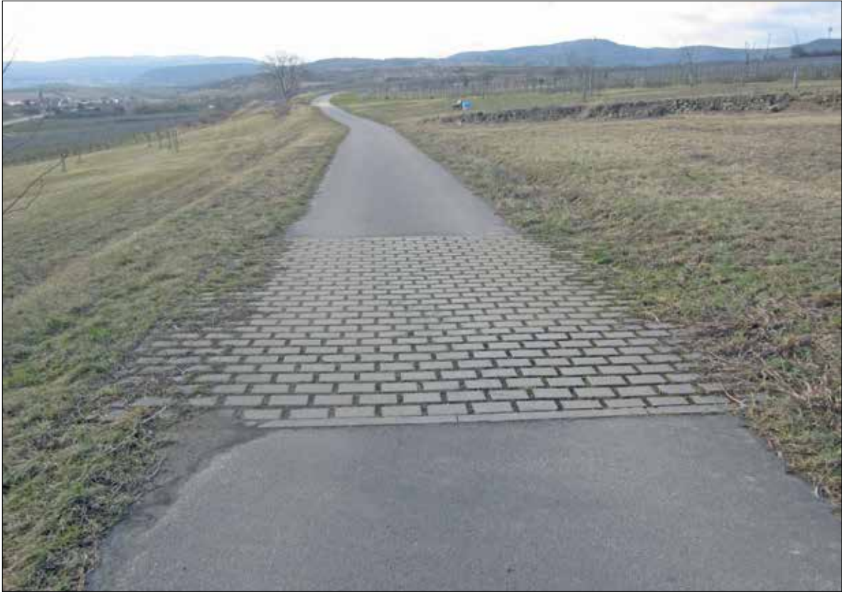
Abb. 2: Ökobrücke Betonsteinpflaster mit Abstandshaltern (Flurbereinungsverfahren „Herxheim am Berg VI“)
