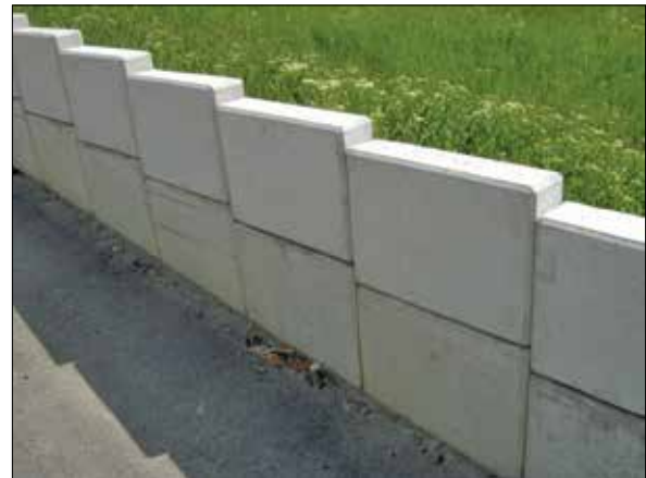
Abb. 13: Winkelstützmauer, Ensheim (ADD)
