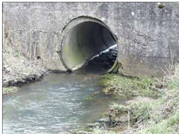
Abb. 15: Zu gering dimensionierter Durchlass mit glatter Sohle.
