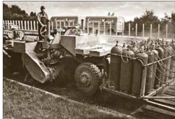
Abb. 1: Das Bild zeigt eine der ersten Warmfräsen vom Typ SF 2450 Anfang der 70er Jahre. (Foto: Wirtgen GmbH)
