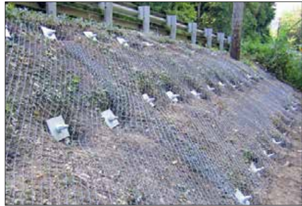
Abb. 16: Netzverhängung einer Böschung, (Geo Stabilization international)
