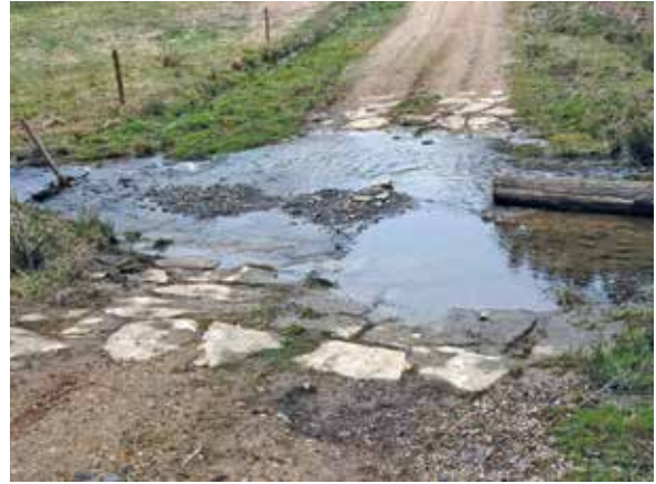
Abb. 13: Der Mineralgemischweg bindet flacher als die Gewässerböschungen in den Mönzbach ein, was aus konstruktiver und ökologischer Sicht als positiv zu bewerten ist.
