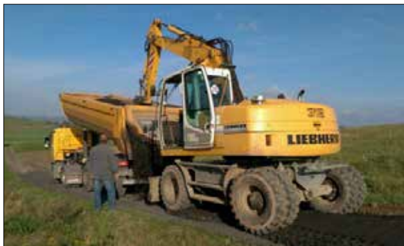
Abb. 5: Der Bagger arbeitete das Material löffelweise aus dem LKW aus.
