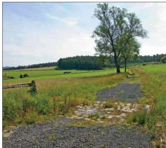
Abb. 27: nach Fertigstellung. Aufgrund des nur temporär wasserführenden Gewässers, ist die Wegfunktion zu keiner Zeit eingeschränkt.
