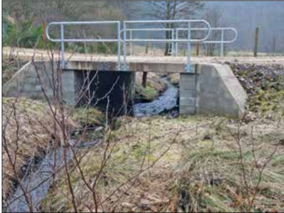
Abb. 3: Brücke im fertigen Zustand. Eine abnehmbare Verkehrssicherung macht das Überfahren mit breiten Fahrzeugen jederzeit möglich.
