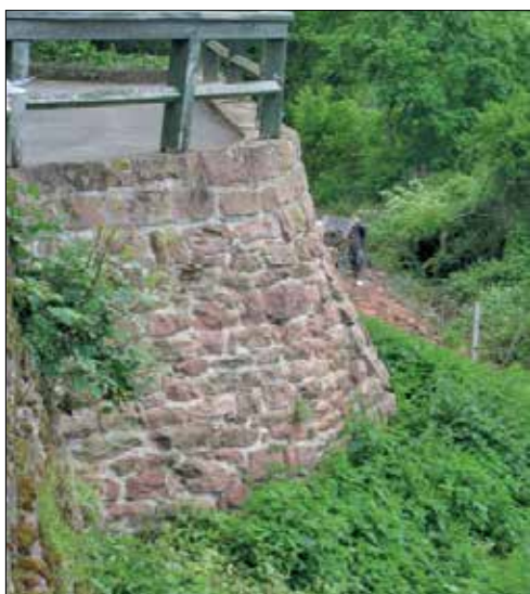
Abb. 14: Verpresste Natursteinmauer, Erlenbach am Main (ADD)
