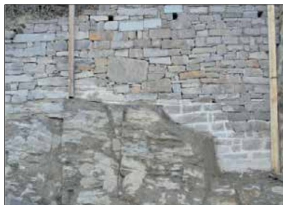
Abb. 4: Trockenmauer saniert, Walporzheim (ADD))
