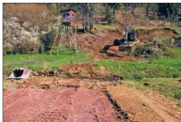
Abb. 2: Absteckung und Bauphase.
