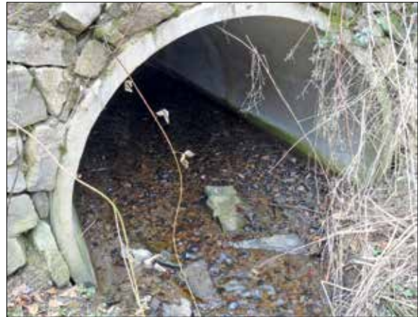
Abb. 20: Die lineare Durchgängigkeit wird durch geeignetes und ortstypisches Sohlsubstrat gewährleistet.
