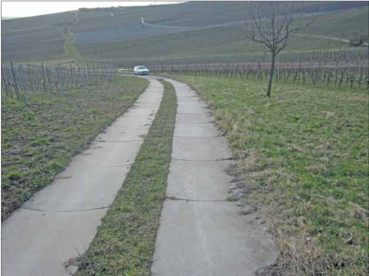
Abb. 1: Ökobrücke Betonplattenspurbahn, Breite 1,20 m (Flurbereinungsverfahren „Hahnheim-Knopf“)
