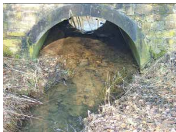
Abb. 16 u. 17: ca. 15 Jahre nach Umbau stellt sich die Anbindung an das Ober- und Unterwasser positiv dar. Aufgrund einer ausreichend kurz gewählten Bauwerkslänge stellen sich gute Beleuchtungsverhältnisse ein.
