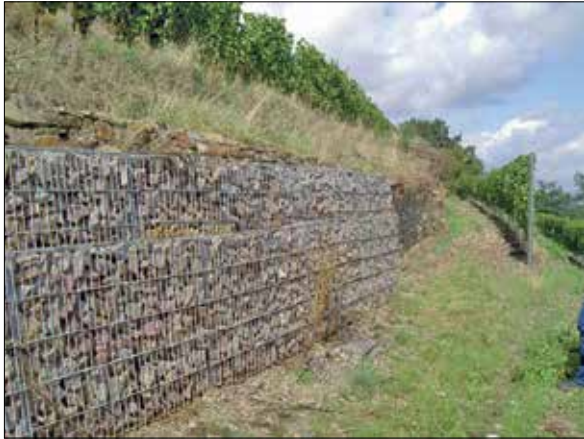
Abb. 11: geschüttete Gabione, Güls (ADD)
