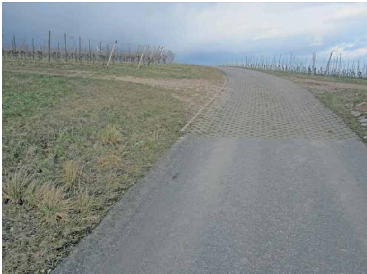
Abb. 3: Ökobrücke Rasengitterplatte (Flurbereinungsverfahren „Ensheim-Projekt I“)
