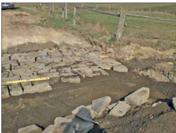
Abb. 25: Bau der Furt mit sohlgleicher Anbindung an das Gewässer.
