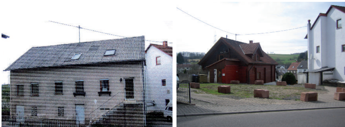
Abbildungen 24/25: Beispiel einer Leerstands- beseitigung durch Abriss 51
