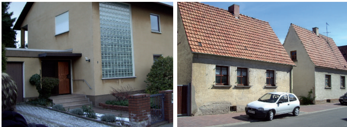
Abbildung 9/10: Wohngebäude mit Modernisierungs- und Unterhaltungstau 29
