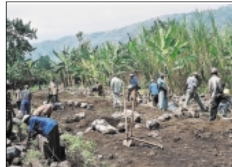
Fundamentarbeiten zum Bau einer Schule im Distrikt Muhebo (Foto: Marion Hilden)
