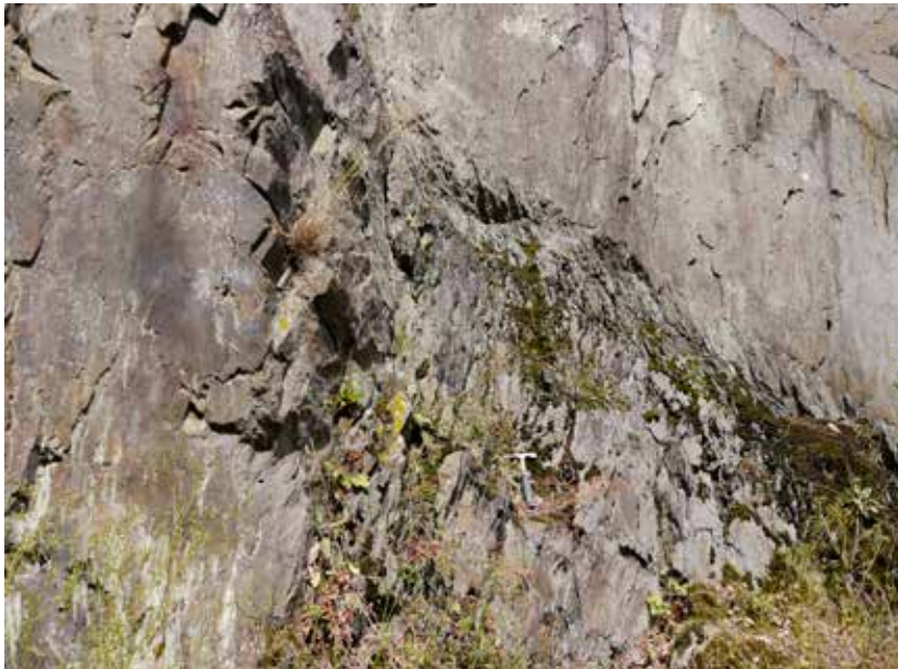
Abb. 2.3: Sandige Schiefer und Sandsteine des Mittelsiegens in Normallagerung. Die Schichtflächen fallen nach rechts ein (Foto: J. Gad). TK 25 Blatt 5312 Hachenburg, am Kloster Marienstatt; UTM32-Koordinaten E: 415453, N: 5615350.
