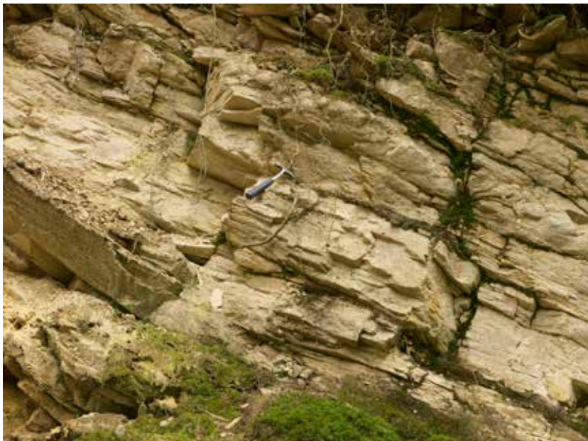
Abb. 2.7: Hellgraue quarzitisches Sandsteine und Quarzsandsteine des Ems-Quarzits s. l. (Foto: J. Gad). TK 25 Blatt 5612 Bad Ems, nördlich Kadenbach; UTM32-Koordinaten E: 409376 N: 5583667.
