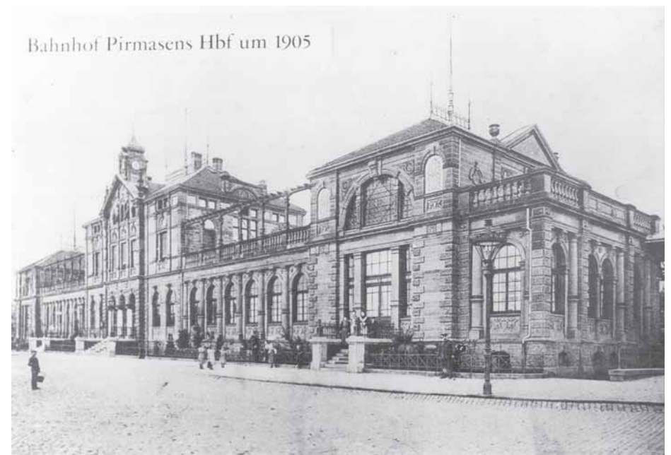
Der erste Pirmasenser Hauptbahnhof war zweifelsfrei ein repräsentativer Prachtbau. (Beide Aufnahmen Sammlung Klaus Franck)
