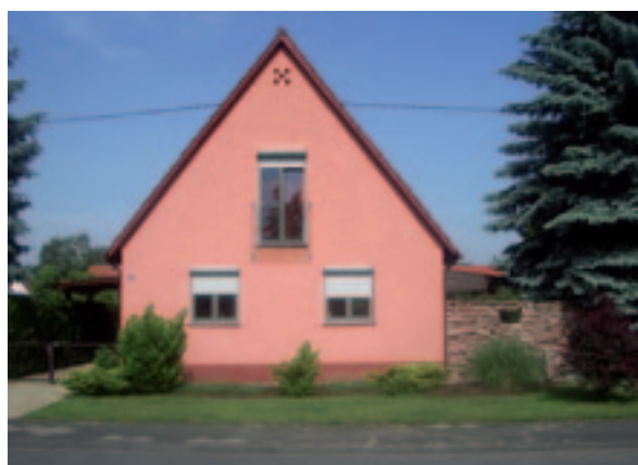
Abbildung 37: Baustilwahrende Teilsanierung – Beispiel Worms (eigene Aufnahme)
