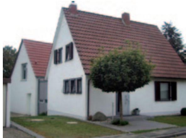
Abbildung 30: Beispiel für Gebäudeanbau in Worms (eigene Aufnahme)
