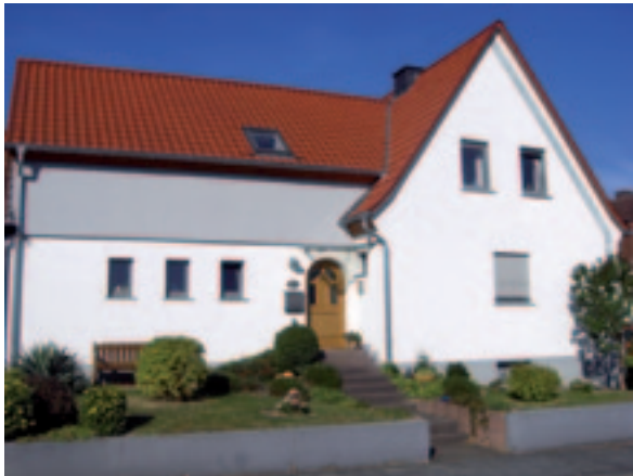
Abbildung 29: Beispiel für Gebäudeaufstockung in Wittlich (eigene Aufnahme)
