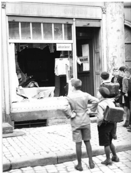
Geschäftshaus Oppenheimer nach dem Pogrom am 10.11.1938
