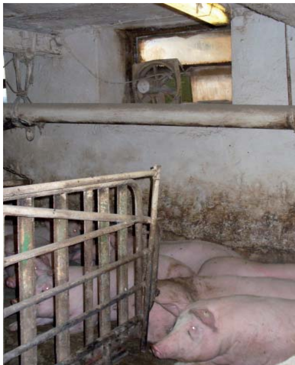
Abb. 19: Schweinehaltung mit Abluftventilator
