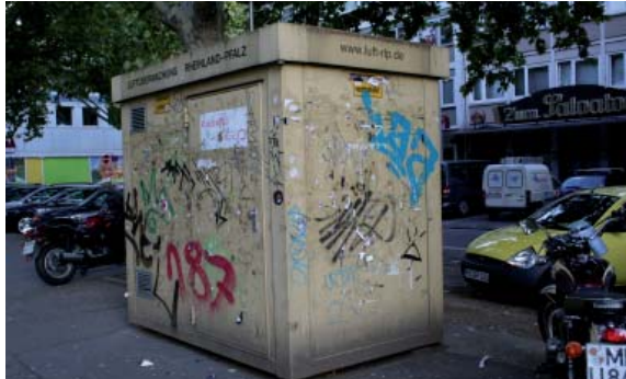
Abb. 2: Messstation in der Großen Langgasse vor dem Besprühen mit Graffiti
