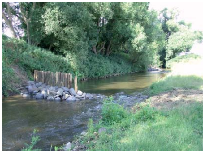
Abb. 101: Strömunglenker zur Unterstützung der dynamischen Eigenentwicklung am Unterlauf der Nette
