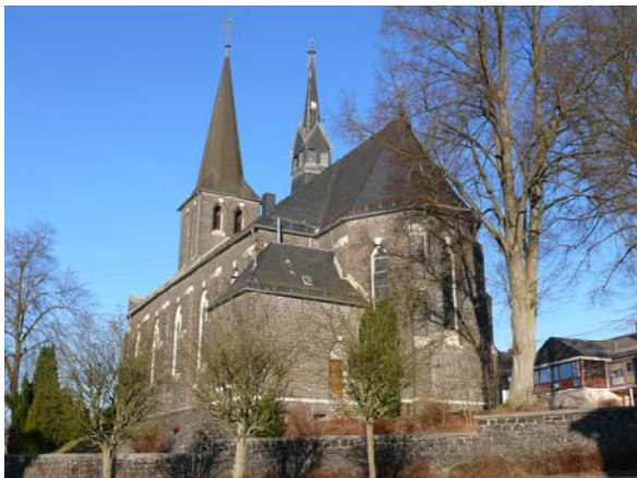
Foto: Kirchengebäude in Rosenheim mit Basaltmauerwerk
