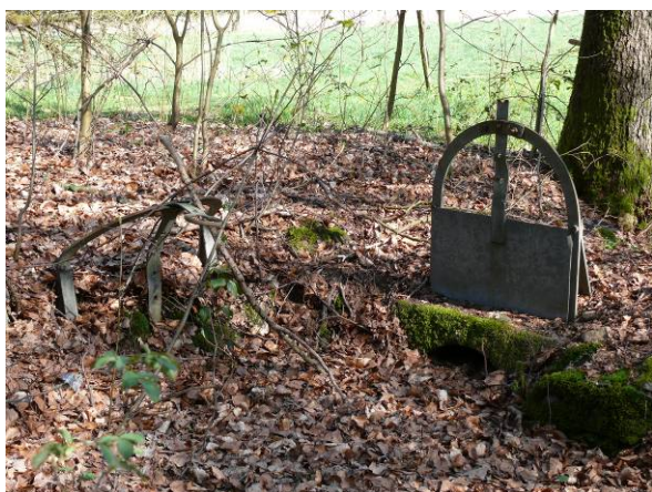
Foto: Schleuse einer historischen Wiesenbewässerungsanlage bei Astert
