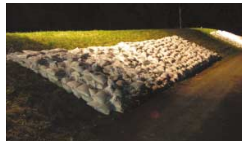
Sicherung der luftseitigen Böschung an einem Deich am Rhein.
