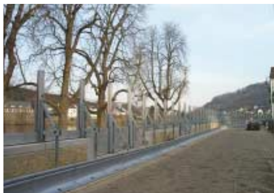
Hochwasserschutz Oberbillig – zentraler Dorfplatz, Hochwasserschutz-Mauern mit Durchgangsbereichen, mobilem Dammbalkensystem im Teilaufbau und Anprallschutzsystem.
