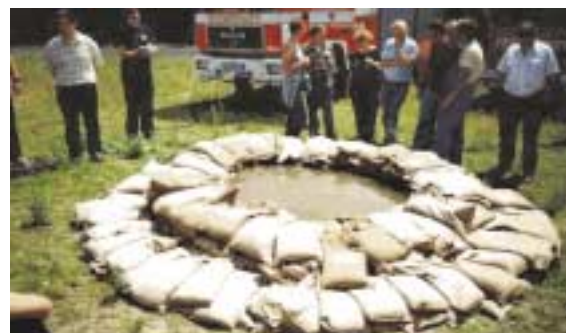
Ringdamm aus Sandsäcken bei einer Übung
