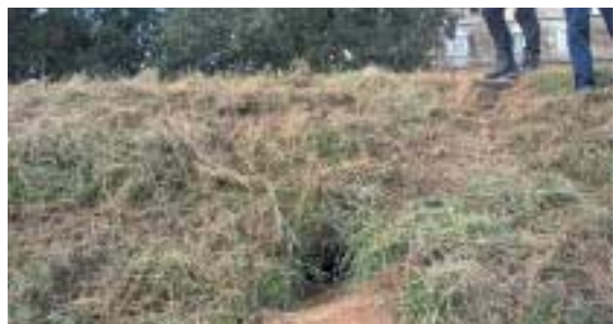
Wühlтиergänge sind nicht immer gleich erkennbar. Die regelmäßige Maht ermöglicht eine leichtere Kontrolle.
