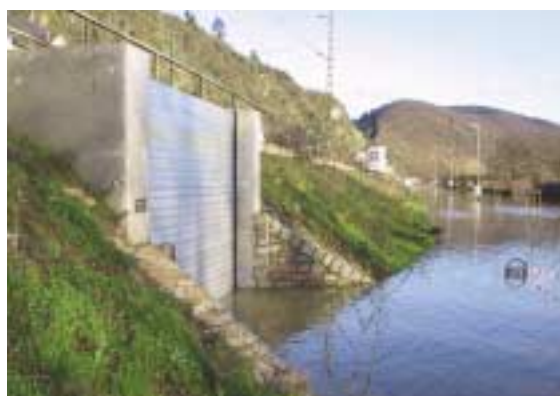
Hochwasserschutz Braubach-Altstadt, Deich, kombiniert mit Drittnutzung (Bahndamm) und Deichscharte mit Dammbalkensystem verschlossen.
