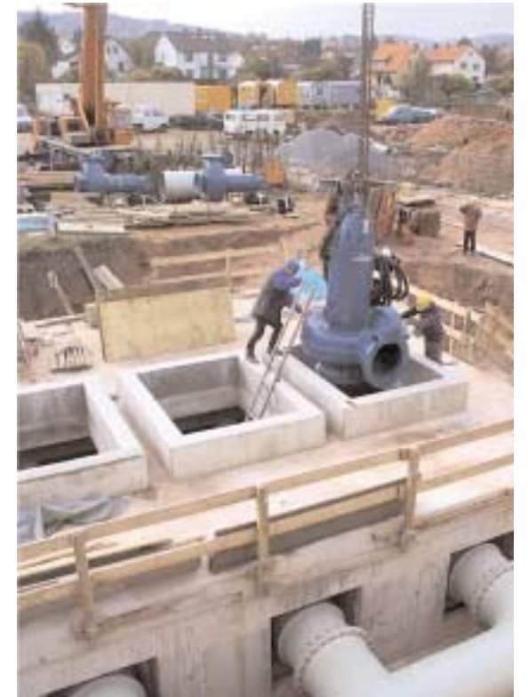
Bauphase bei einem unterirdischen Schöpfwerk – Einbevorgang einer Pumpe
