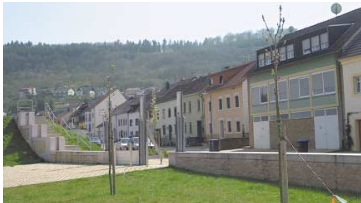
Hochwasserschutz Lieser, zentraler Deichdurchlass (Verschluss durch mobiles Dammbalkensystem) mit seitlich integriertem Pumpwerk und Dammbalkenlager
