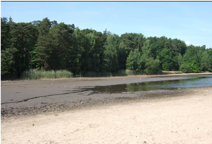
Vogelwoog: Wasser wurde abgelassen zur Reparatur des Damms
