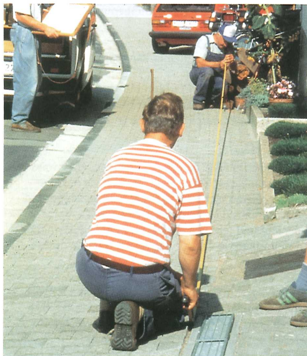
Abb. 22: Bei der Ortsregulierung werden die Eigentumsgrenzen für eine zukunftsgerechte Nutzung neu festgelegt, die rechtlichen Verhältnisse geordnet sowie Planungen der Gemeinden und Dorferneuerungsmaßnahmen umgesetzt.
