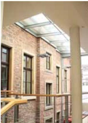
**Erweiterung ohne Substanzverlust am Kulturhaus Oberwesel:** Durch einen verglasten Zwischentrakt ist der alte Klinkerbau mit einem Neubauteil zusammengefügt worden. Trotz Erweiterung bleibt die **sehenswerte Fassade erhalten**. Die Außenwand wird zur Innenwand und es entsteht ein Raum mit besonderem Charakter und hoher Qualität.
