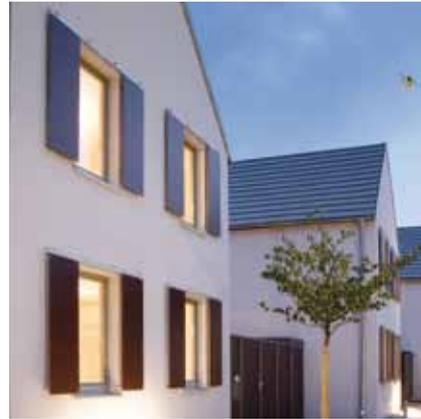
Für **Neubauten** sind die herkömmlichen Fenster-(Klapp-)läden keine zeitgemäße Lösung. Eine interessante Neuinterpretation in Form von **Faltläden** kann für einen Neubau interessante Akzente setzen.
