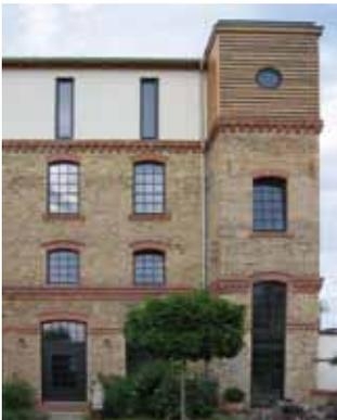
Wird ein historisches Gebäude in der Höhe erweitert, ist besondere Sorgfalt erforderlich. Im abgebildeten Beispiel wurde ein gründerzeitlicher Gewerbebau zum Wohngebäude umgenutzt und aufgestockt. Die Erweiterung ist durch die helle Putzfassade deutlich von der Backsteinfassade abgesetzt und lässt dadurch die **ursprünglichen Proportionen des Gebäudes sichtbar**. Die Fensterschlitz greifen die Fensterachsen auf, verwenden jedoch eine eigene, moderne Formensprache.
