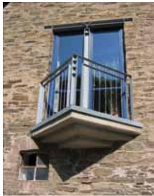
In die Giebelwand einer alten Scheune in Kobern-Gondorf an der Mosel wurde für den Balkon eine **neue Öffnung** eingeschnitten. Diese wurde im Kontrast zum alten Gebäude **modern gestaltet**. Der im Detail sorgfältig ausgebildete Sturz aus Metall und die Farbgebung der Türen machen deutlich, dass hier **etwas Neues eingefügt** wurde. Die Fortentwicklung täuscht nicht vor, schon immer da gewesen zu sein, sondern schafft eine eigene Qualität, die das alte Gebäude jedoch nicht in Frage stellt.
