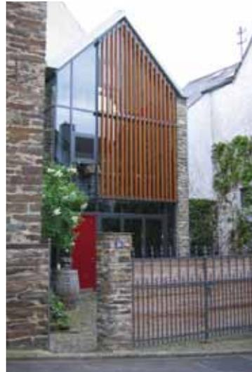
Ein vorbildliches Beispiel von der Mosel: Das alte aus Bruchsteinen gemauerte Wohngebäude wurde im Hof durch einen zeitgemäßen Neubau ergänzt, der in seiner **Form und Höhe dem Altbau entspricht**. Die moderne, offene (Isolier-) Glasfassade nutzt die Möglichkeiten heutiger Baustoffe aus und trägt dem Umstand Rechnung, dass im eng bebauten Ortskern helle Räume nur durch **große Fenster** zu erreichen sind.
