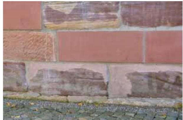
Vergleichen Sie: Der linke Teil der mit Naturstein verkleideten Mauer wurde fast bündig verfugt; die Fugen werden dominanter Teil der Mauer, die Steine verkommen zum „flachen“ Dekor. Der rechte Teil der Mauer behält durch die dezente Verfugung seine plastische, lebendige Wirkung.
