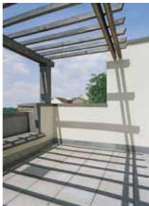
Ein Beispiel aus Bacharach zeigt, wie ein Fachwerkhaus mit einem Balkon ergänzt werden kann, ohne das Gebäude selbst völlig zu verändern: Der massive, aber schlicht gestaltete Balkon, eine **vor die Fassade** gestellte Holzkonstruktion, fügt sich ein, ohne zu dominieren. Das Dach besitzt **dieselbe Neigung** wie das Dach des Hauptgebäudes, ist jedoch eigenständig. (Bacharach)
