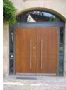
**Vorbildlich:** Ein eckiges Portal in einer gewölbten Wandöffnung muss kein Widerspruch sein: Durch die Verglasung der „Restflächen“ bleibt die **ursprüngliche Großform sichtbar.**
