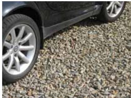
Auch einfache, versickerungsfreundliche Stellplatzoberflächen aus verdichtetem, grobem Schotter bilden eine Alternative zu hoch versiegelnden Flächenbefestigungen. Insbesondere **schwarzer Basaltschotter** oder gebrochene Steine aus dem örtlich anstehenden **Quarzit** nehmen Farbtöne aus der Umgebung auf.
