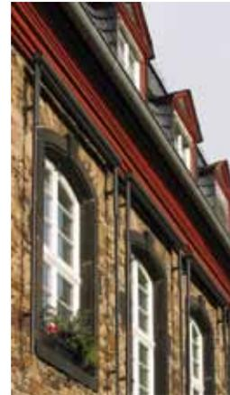
Eine gute Methode, alte Gebäude mit einer zeitgemäßen Verdunkelungsmöglichkeit nachzurüsten, sind **vorgesetzte Konstruktionen**, die ohne einen Eingriff in die Substanz angebracht (und bei Bedarf schadlos wieder entfernt) werden können. Sie sind als modernes Bauteil erkennbar und verfälschen das Erscheinungsbild des Fensters nicht in unangemessener Weise. Die Beispiele aus Bad Salzig und Koblenz-Horchheim zeigen zudem eine gelungene farbliche Integration.
