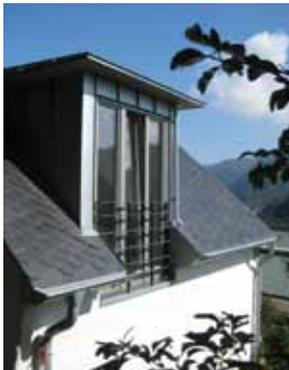
Jedes zusätzliche Bauteil auf der Dachfläche wird optisch als Auflast wahrgenommen. Wo die Höhe des Dachraumes für einen Aufenthaltsraum nicht ausreicht und dementsprechende **größere Aufbauten** erforderlich sind, ist es daher ratsam, diese **auf die Außenwand des Gebäudes aufzusetzen**. Damit wird vermieden, dass die Dachfläche durch eine große Gaube „erdrückt“ wird. Vorbildlich gelöst in Boppard-Hirzenach: Zwerchgaube mit raumhohen, sogenannten „französischen“ Fenstern.
