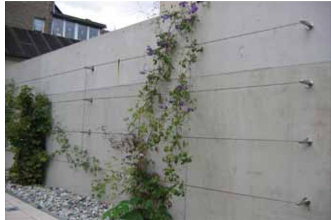
benötigen eine Rankhilfe und sind in der Regel unproblematisch für die Fassade, da sie keine direkte Verbindung mit der Hauswand eingehen. Ob moderne **Stahlseilssysteme** oder die klassischen **Rauten- oder Rechteckleisten aus Eichenholz**, ob naturbelassen in Holz oder lackiert – auch hier gilt, je einfacher und schlichter, desto besser kommt die Pflanze zur Geltung.
