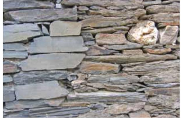
Vorbildlich: Hier wurde ein alter schadhafter Mauersockel aus Sandstein ausgebessert. Die neu eingefügten Steine besitzen eine glatte Oberfläche, da die heute erhältlichen Steine maschinell hergestellt werden. Der Mauer sieht man ihre „**Geschichte**“ an. Nachträglich Eingefügtes bleibt als solches sichtbar. Prinzip „**Ehrlichkeit**“.
